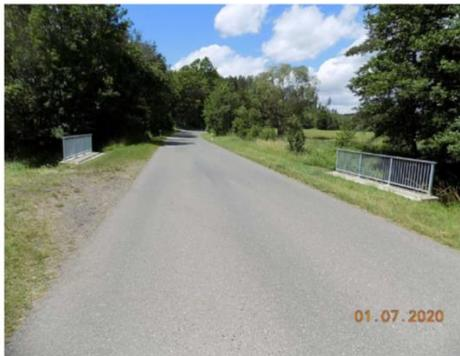
2020\_H\_FAHRBAHN\_SCHUTZEINRICHTUNGEN AM FAHRBAHNRAND FEHLEN
