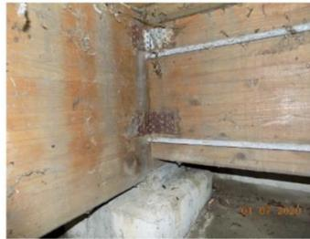
2020\_H\_ÜBERBAU\_VERBINDUNG\_ENDQUERTRÄGER MIT LÄNGSTRÄGER\_VERROSTET
