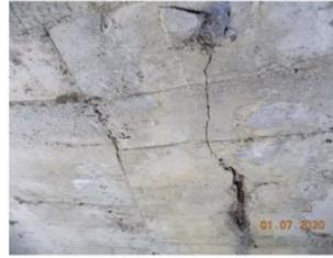
2020\_H\_WANDUNG\_LÄNGSRISS MIT ABPLATZUNG UND FREILIEGENDER BEWEHRUNG
