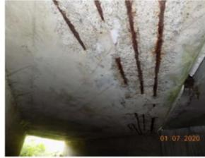
2020\_H\_ÜBERBAU\_BEWEHRUNG\_VERROSTET MIT QUERSCHNITTSCHWÄCHUNG
